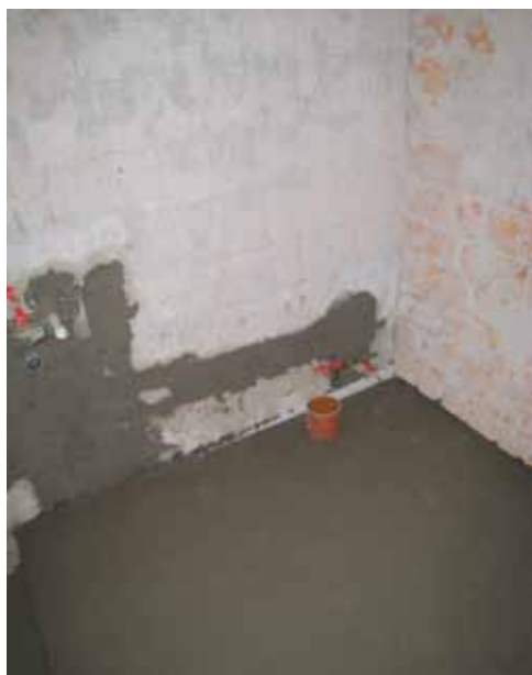
9. dag – Og det nye gulv bliver også lagt. Endelig ikke betræde.
