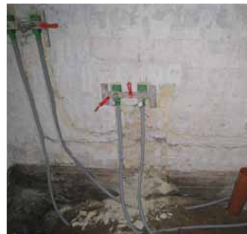
4. dag – Nu er rørføringen til bruser, håndvask og toilet etableret, det ser indviklet ud – man må håbe at de har monteret det rigtigt
