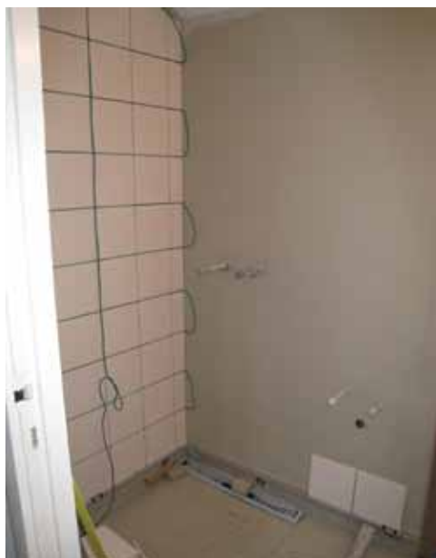
18. dag – Så er murerne i gang med opsætning af fliser – det ser svært ud, men det begynder at ligne et badeværelse
