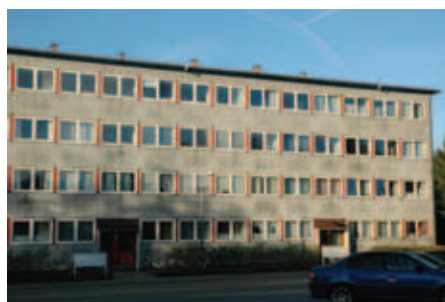
En af de boligblokke på Karensvej der snart skal renoveres
