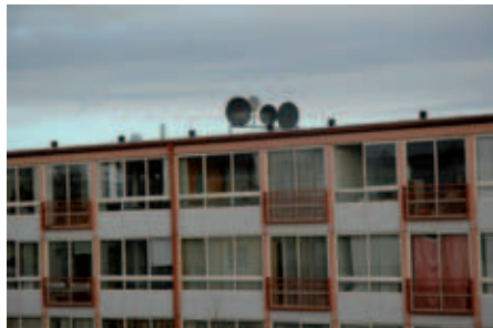
Parabolerne i Kjærslund i Viby er placeret på taget
