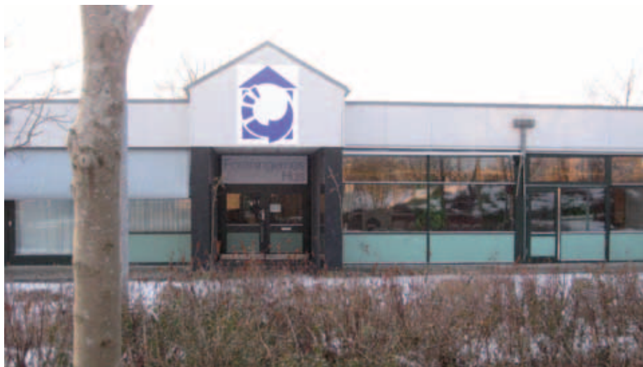
I denne bygning bliver Mediehus Gellerup til.
