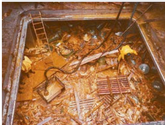
Jysk Kloak Service stod for at tømme skibet. For at beskytte pumpen mod at blive tilstoppet, var pumpen omgivet af en gitterboks.
