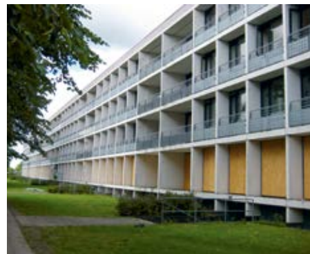
I denne bygning bor en af de beboere, der ankede, så den kan ikke rives ned endnu.
