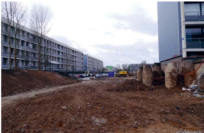
Lige her er man ved at gøre plads til den nye Lottesvej-linje, som skal gå fra Gudrunsvvej og ramme den nye bygade. (Foto af Anett S. Christiansen)
