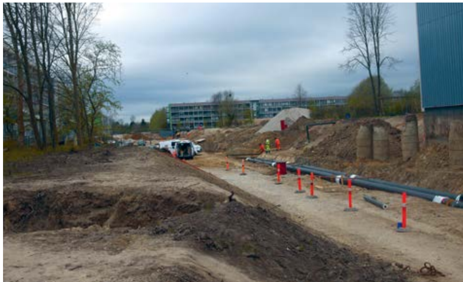
Den ny gennemgående Lottesvej er ved at komme til syne.
