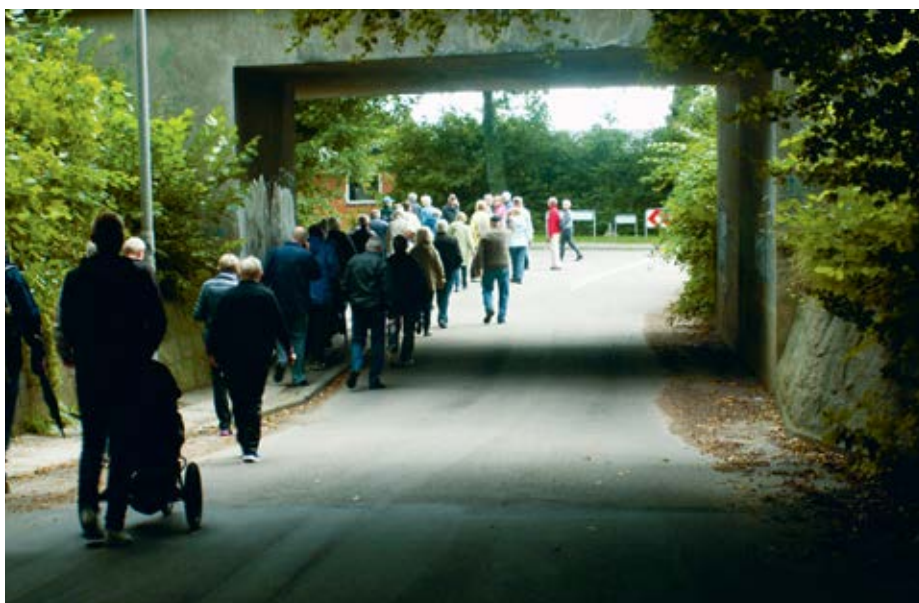
Viadukten under togbanen over Louisevej. På den ene side står der 1928 som årstal for opførelse, og på den anden side 1935 - der gættes på, at viadukten er blevet udvidet, da togbanen blev 2-sporet.
