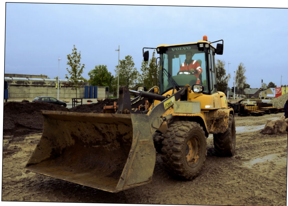
I dag står den på oprydning på byggepladsen.
