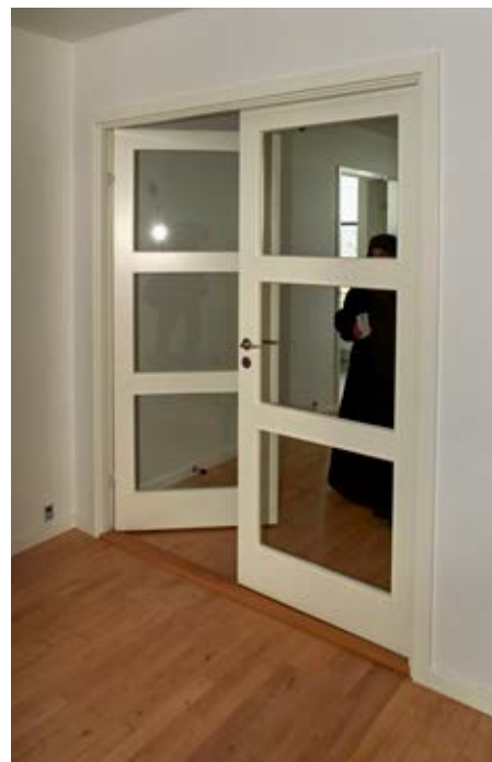
I stedet for en skydedør er der nu kommet glasdøre i stuen.
