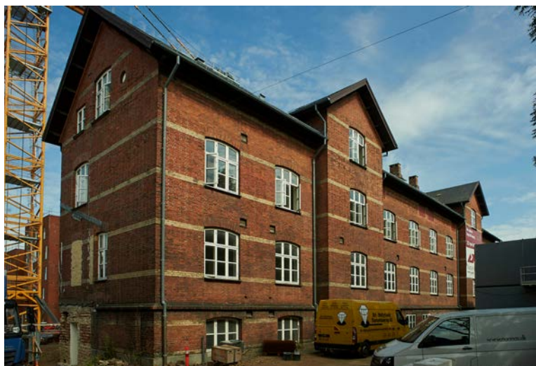
Det gamle garnisonssygehus skal rumme 22 boliger.
