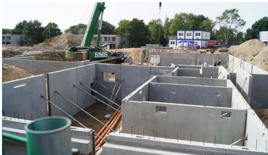
Kælderen i Brabrand Boligforenings nye domicil er dukket op af jorden.
