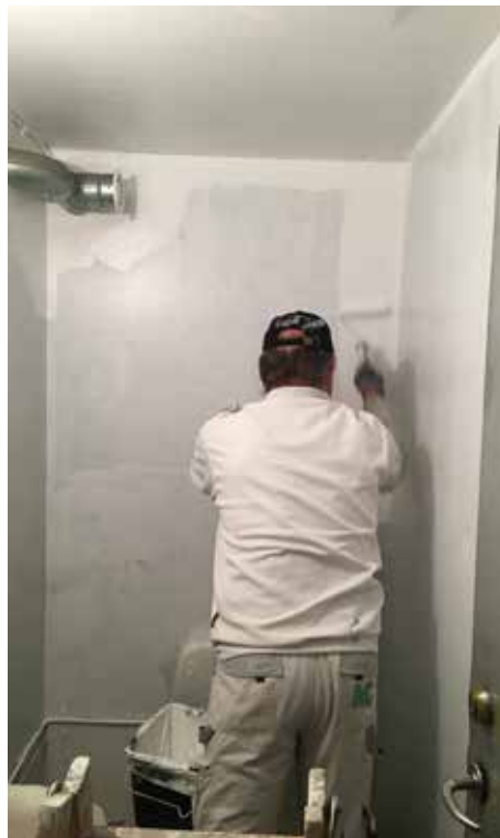
Der males toiletter i Toveshøj.
